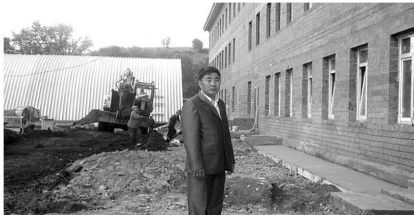
О. Н. Саганов: «Строительство комплекса идет полным ходом».
